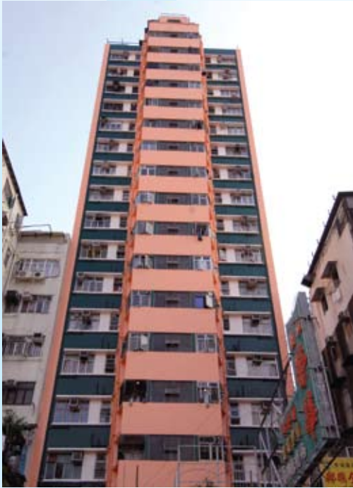
荃灣荃豐大廈復修後之新面貌。
